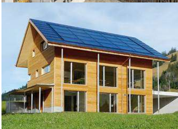
Bâtiment Génie climatique
