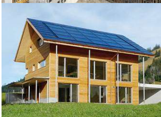
Bâtiment Génie climatique
